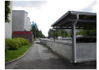
Sisäänajo maanalaiseen pysäköintiin
