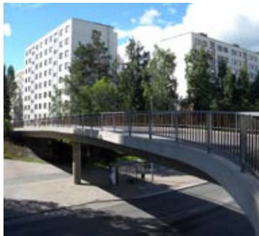
Valtaraitin silta yli Opiskelijankadun.
